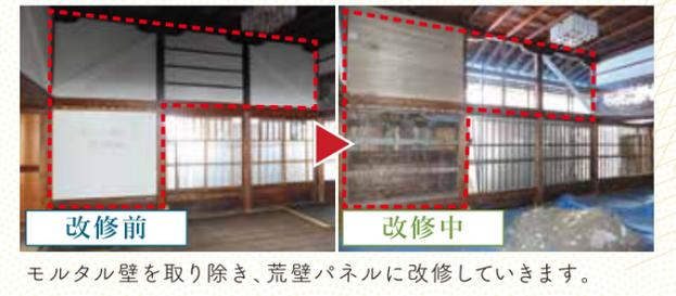
モルタル壁を取り除き、荒壁パネルに改修していきます。
